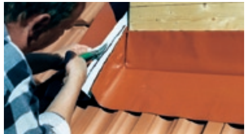
Gaubenanschluss mit Schichtstücken
