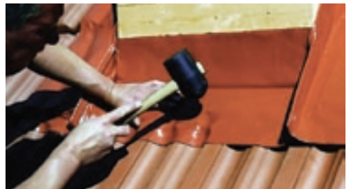
Fertige Kamineinfassung bleiCOLOR-SK (zusätzliche Sicherung der Bleche durch Nägel oder Schrauben)
