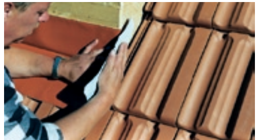
bleiCOLOR-SK ablängen, ankleben und anformen
