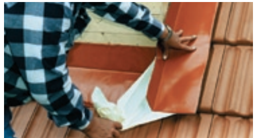
Schutzfolie abziehen
