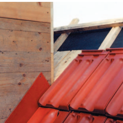
Beispiel einer Kehlschalung aus Holz
