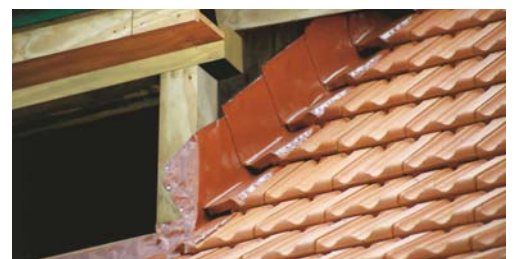
raccord de fenêtre sous-toit avec chevauchement
