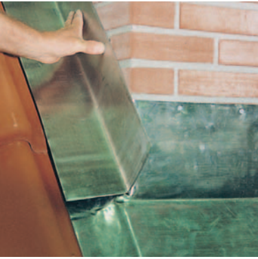
Réalisation d'un solin latéral
